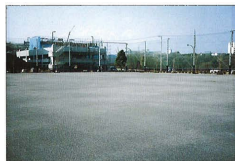
ランドフィルターによる施工後 (透水保水層)
